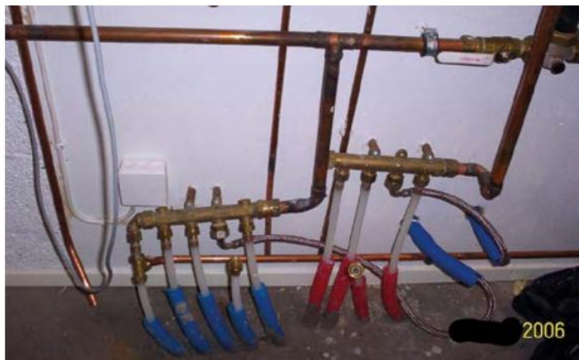
Jakotukkien asennus ja puuttuvat eristykset.
