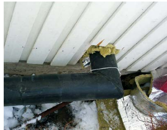
4-putkielementin sisäänmeno lj-rakennukseen
