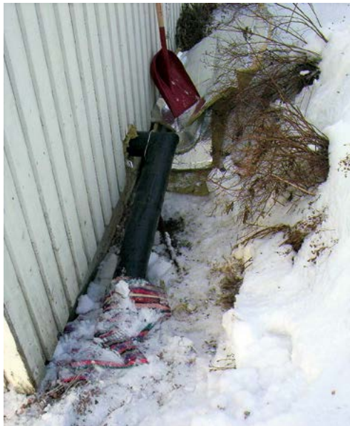
4-putkielementti ja poistettuja lisäeristeitä
