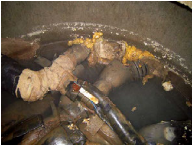
kuva 5. Elementit vedessä; läpiviennit vajaan ja paikkailtu pu-vaahdolla
